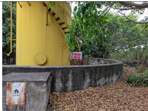
柴油储罐围堰
